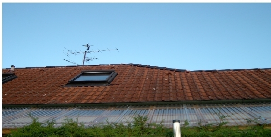
KUPFERFIRST (Fremdprodukt) 2002 montiert! STREIFENBILDUNG mehr KUPFEROXID wie SCHWEFEL im KUPFERSULFAT !
